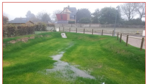
Première mise en eau de l'ouvrage
