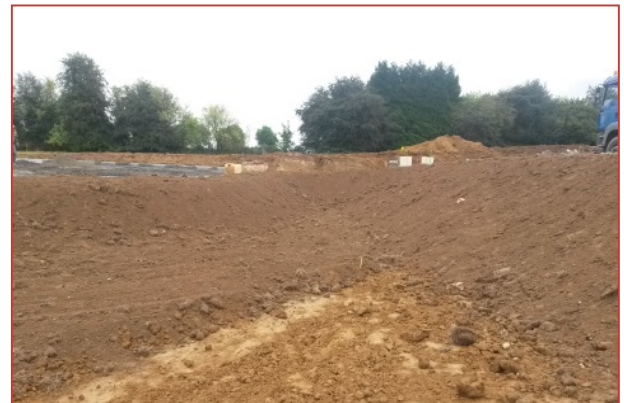
Recapage de la terre végétale
