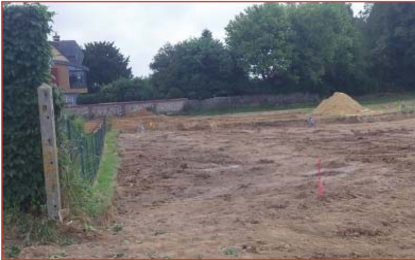
Décapage de la terre végétale
