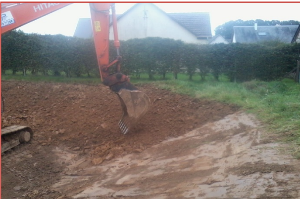
Décompactage et griffage
