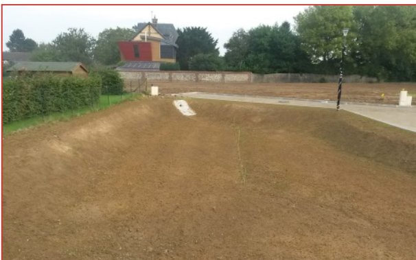
Finition des terrassements
