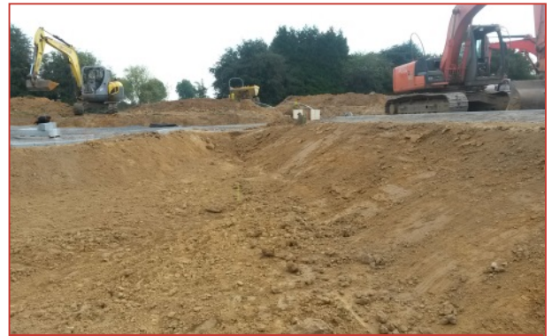
Réalisation des terrassements
